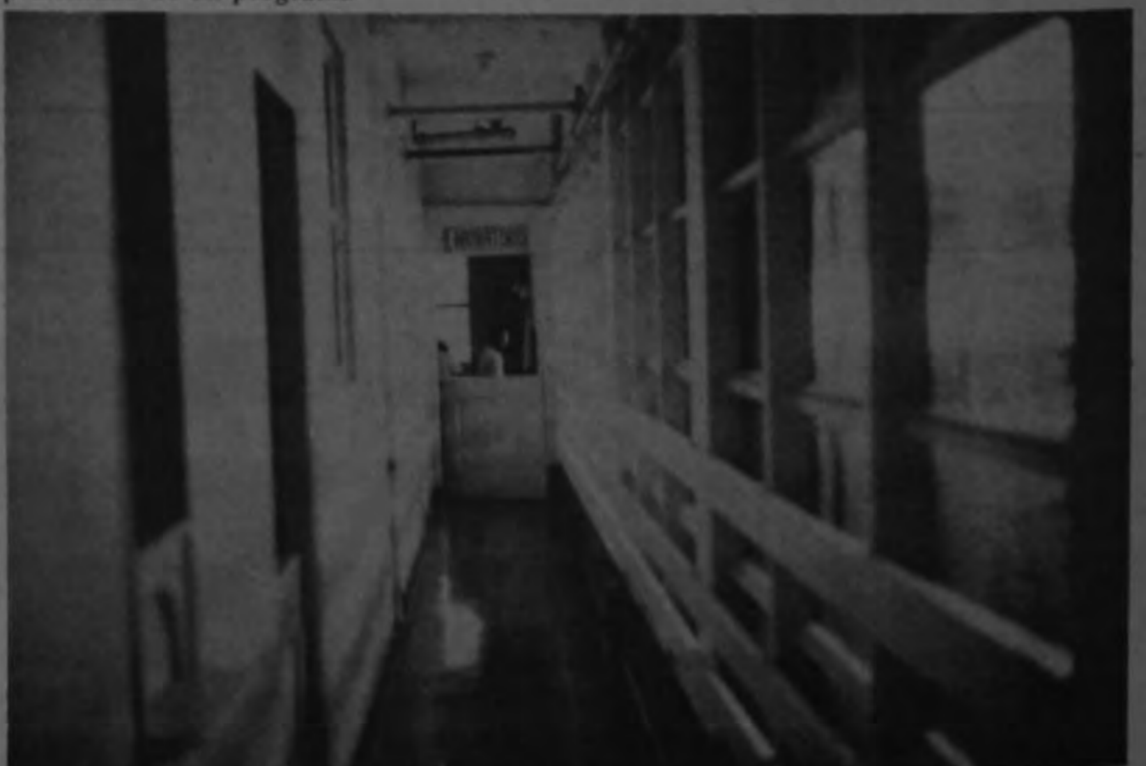
Este es el laboratorio del Hospital de Golfito. Dentro de la nueva organización será trasladado a otro lugar más funcional.
