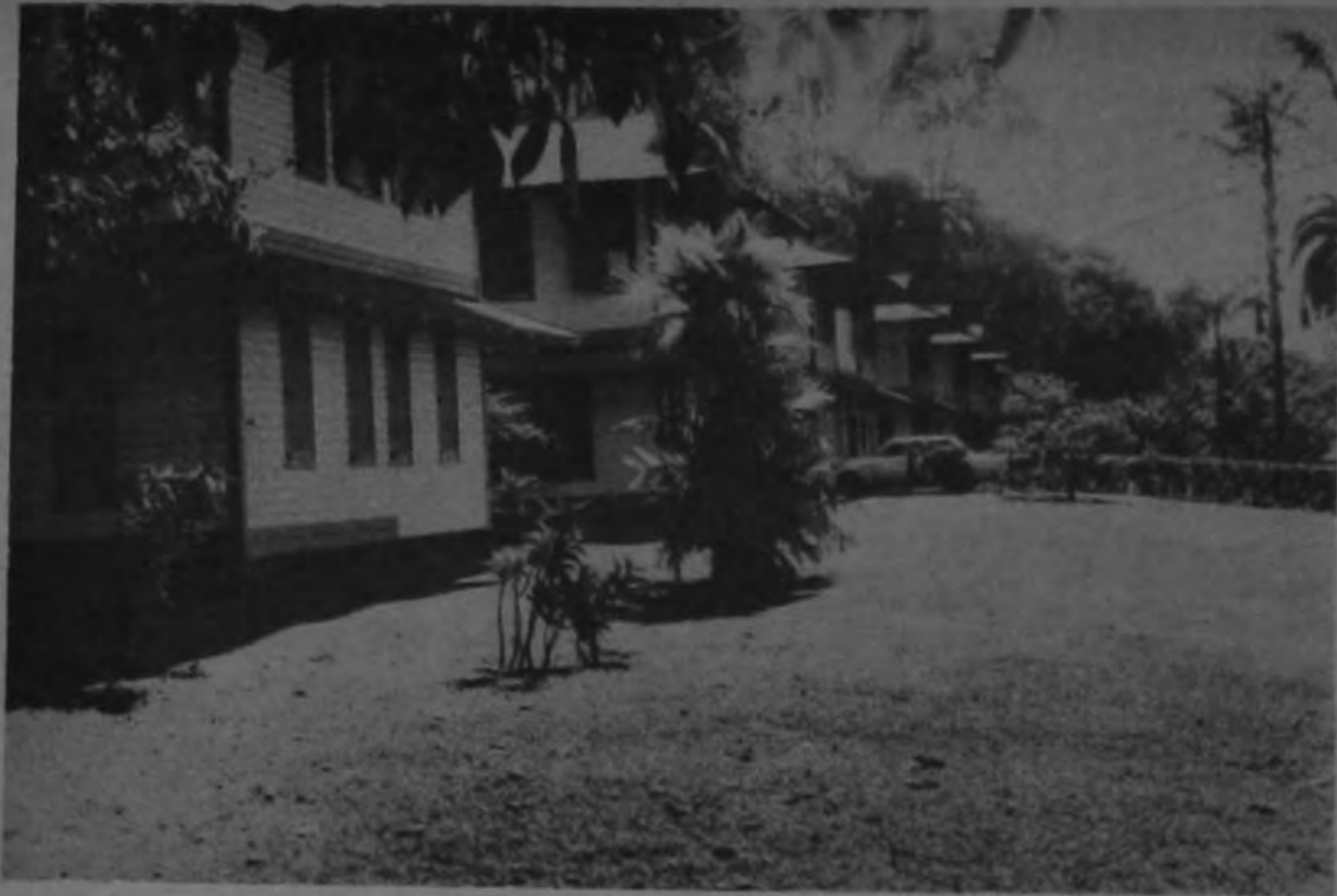
En seis pabellones está ubicado el Hospital de Golfito en la denominada zona americana. Ahora es una institución que permite acceso a toda la población golfitiense.
